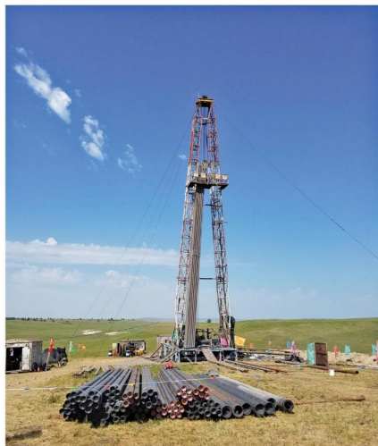
Нефтегазовое бурение глубины 1800 метров в Синьцзянском I-типе Казахстанской автономной префектуры
